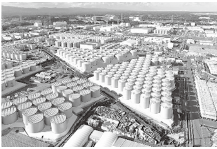
(写真1) 汚染水タンク群
